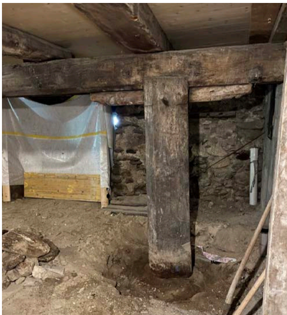
Die Stütze wird trocken gelegt 22.06.2022
