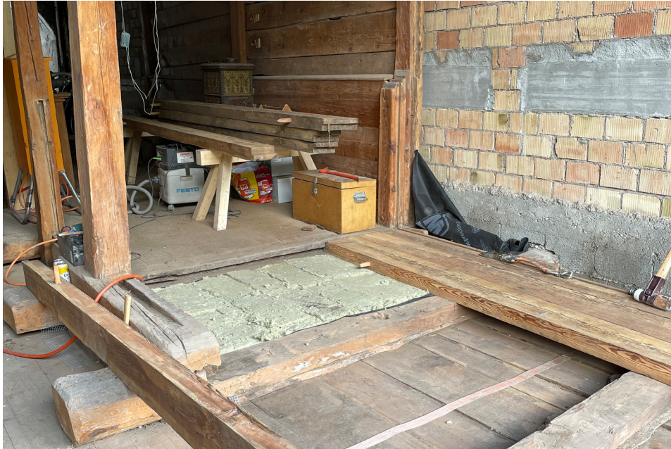
Das erste Bodenfeld wird isoliert 15.08.2022
