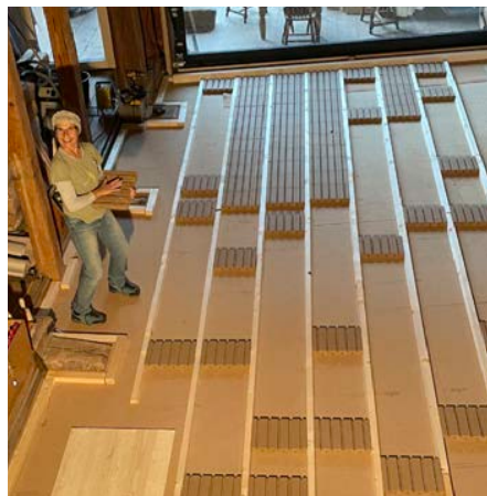
Bodenaufbau Lethermo Trockenlehmplatten
