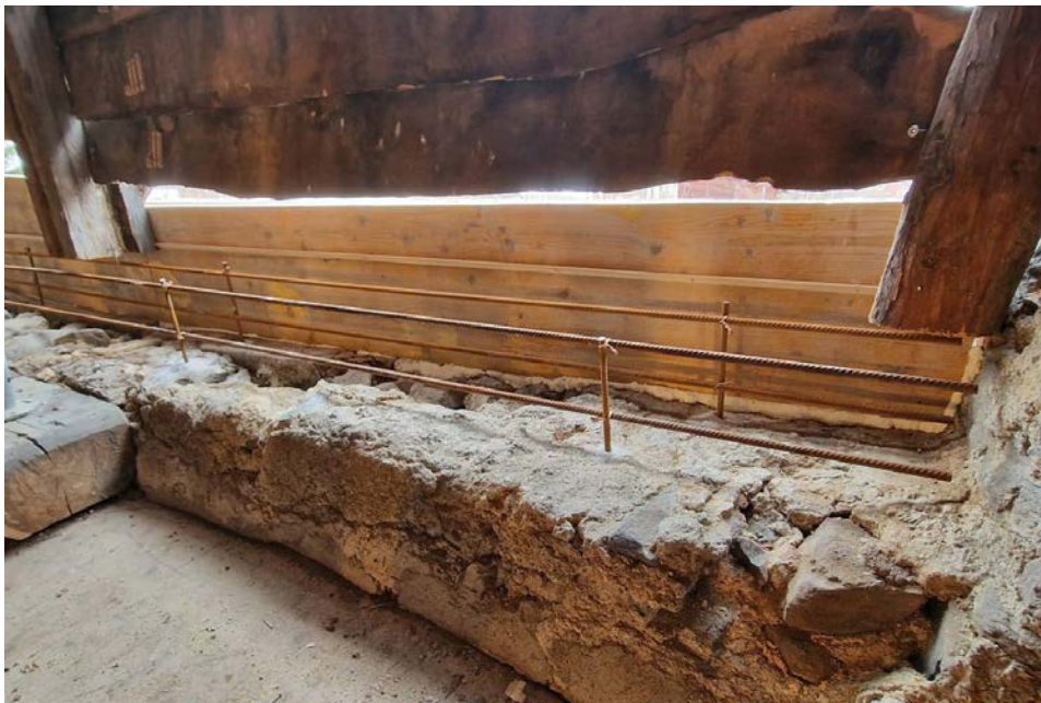
Vorbereitet für den Betonriegel 22.12.2022
