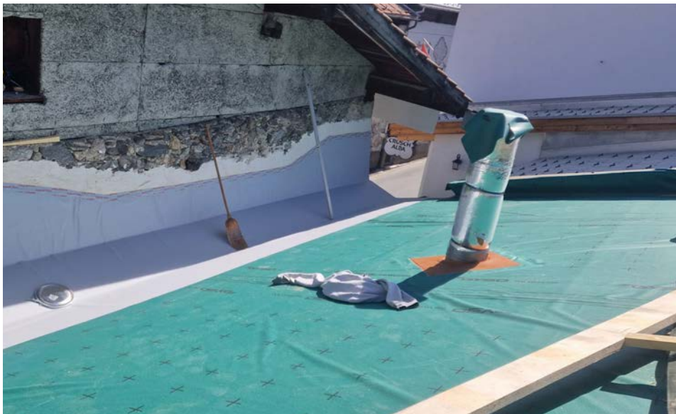
Anschluss Kehle Unterdachfolie 08.04.24
