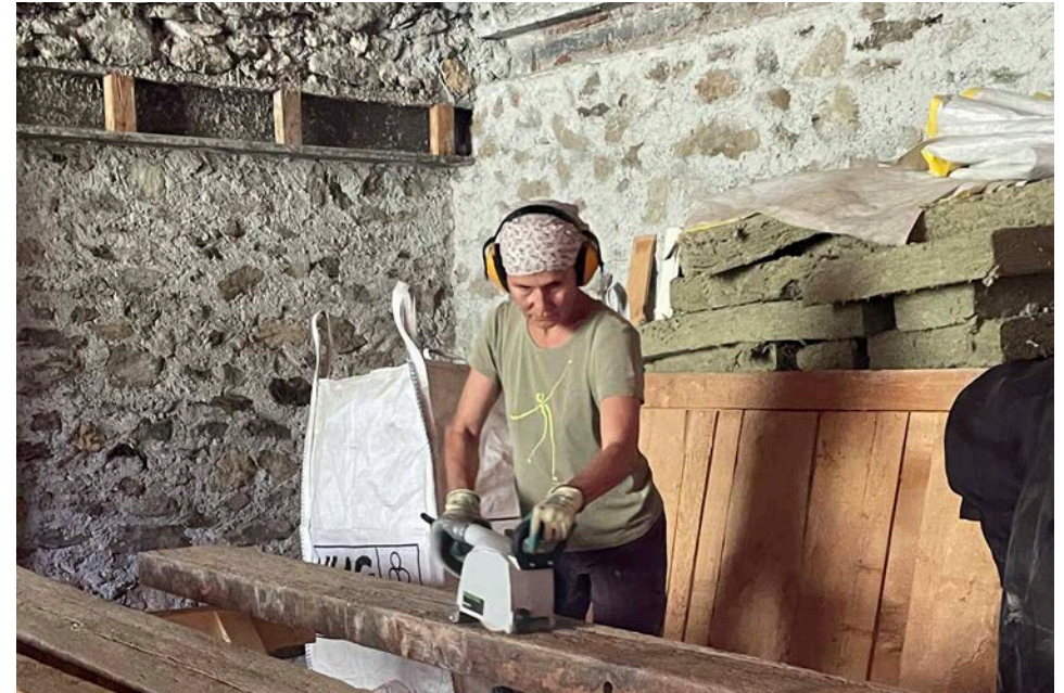
Die Balkenbürstmaschine im Einsatz
