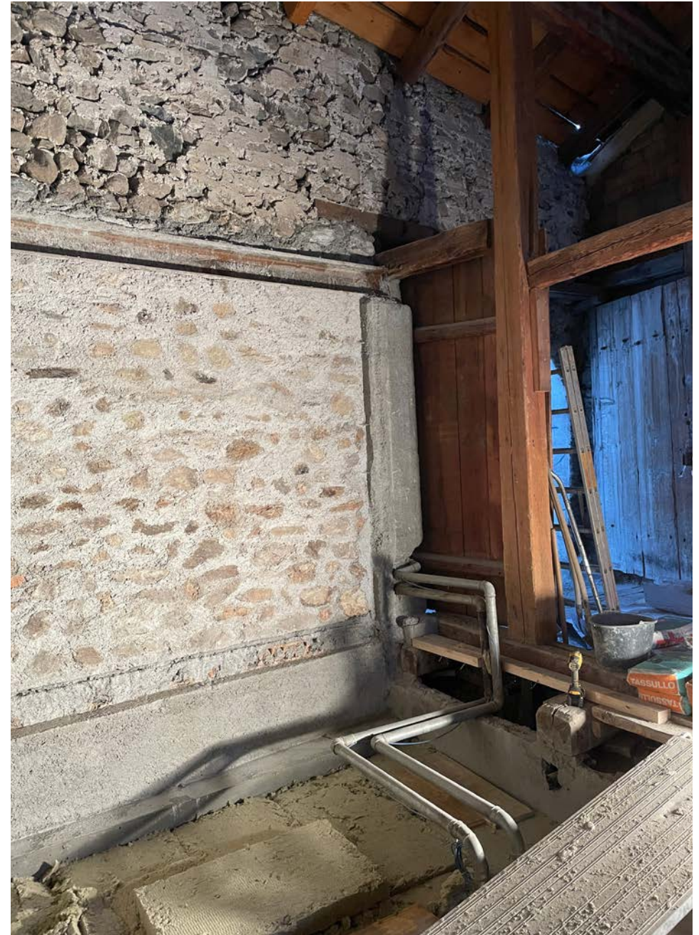
Die Decke über dem Oeltank ist abgebrochen 16.12.2022
