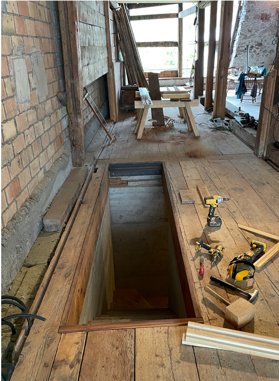
Altholzfutter für die Bodenklappe mit Beschlag
