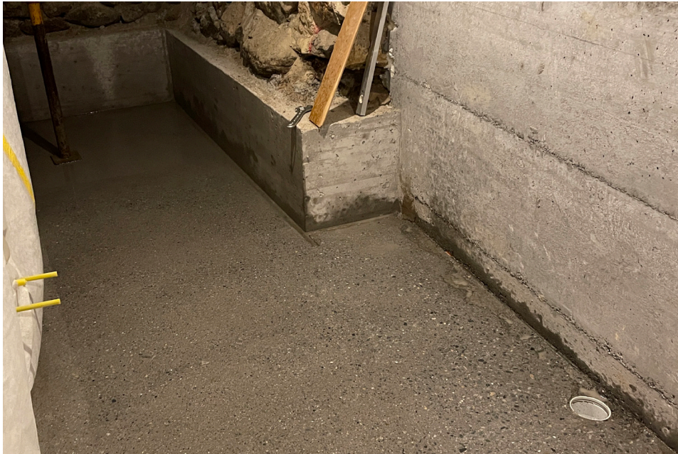
Der Betonboden im UG wird ins Gefälle geschliffen 20.06.2022
