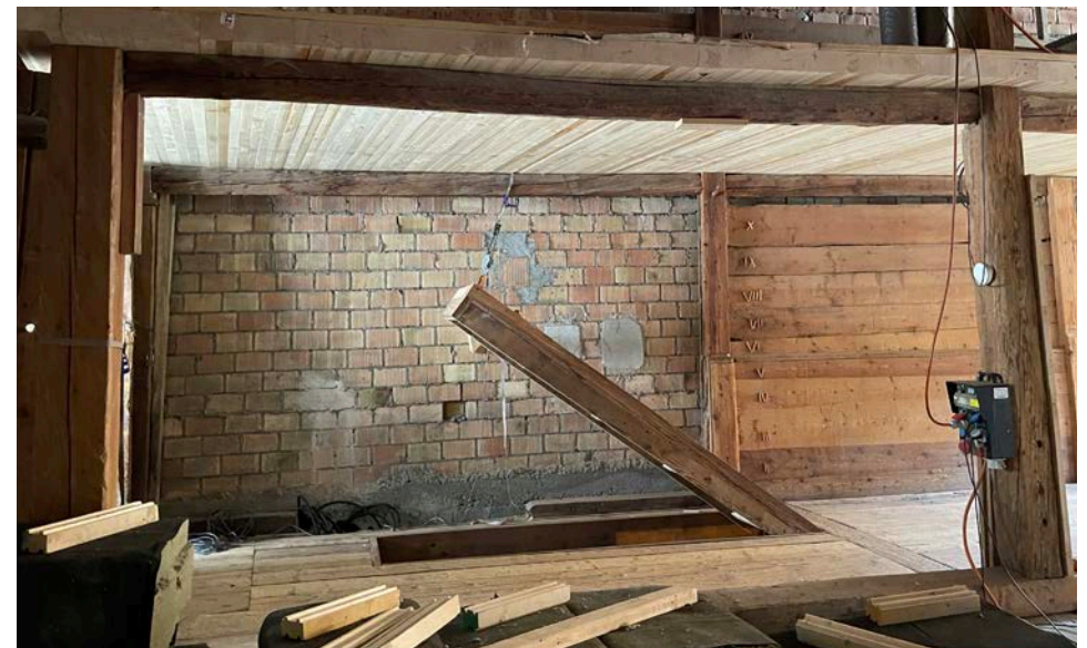
Befahrbare Bodenklappe aus jahrhunderte alten Lärchenbohlen
