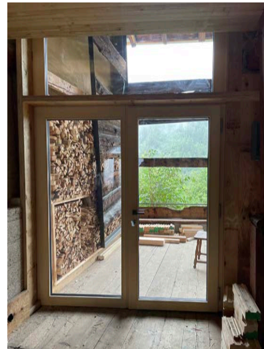
Oben Fenster mit Hubeinrichtung, unten Fenstertüre
