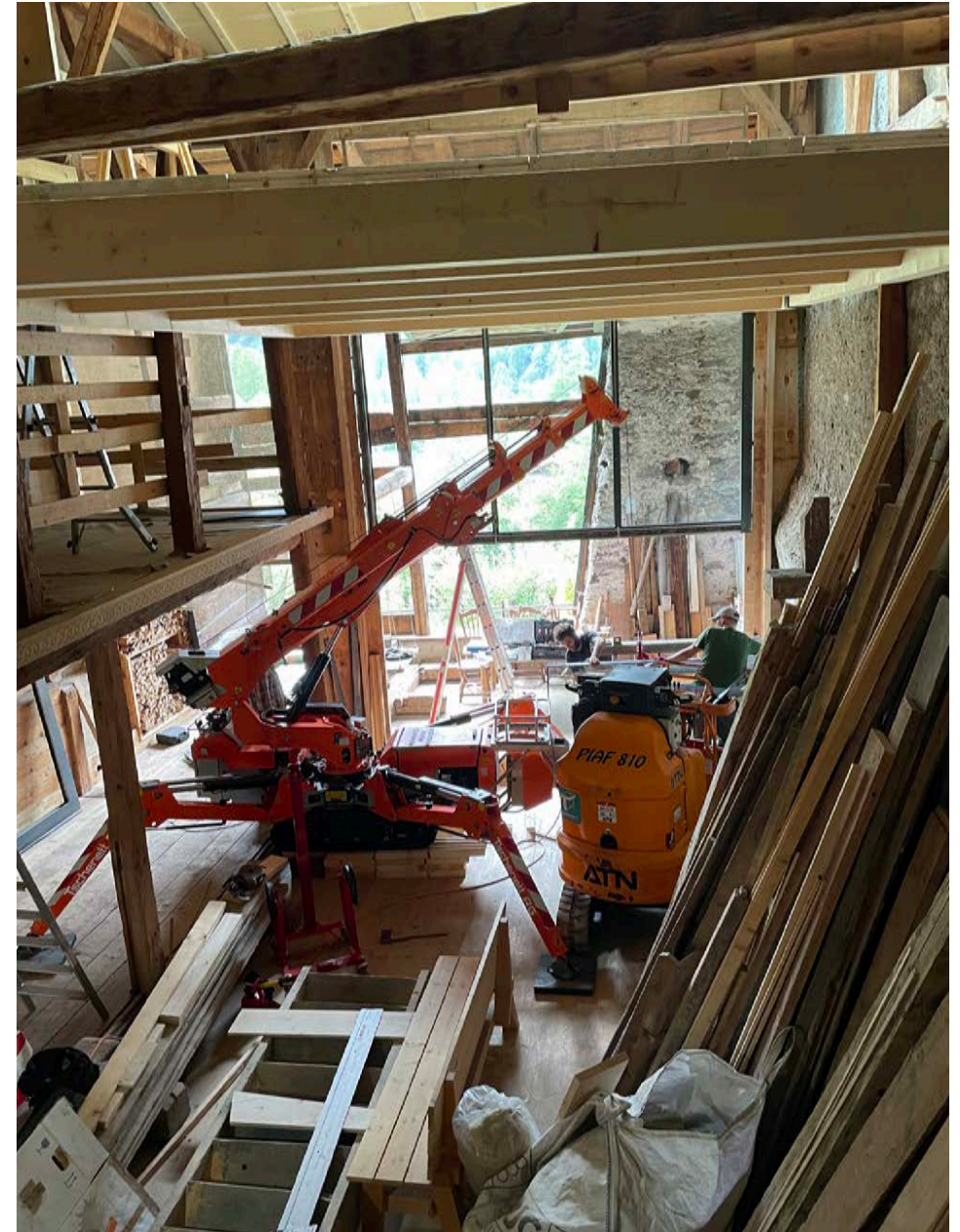
Montage Schwarzstahlfensterfront mit Kran und Hebebühne
