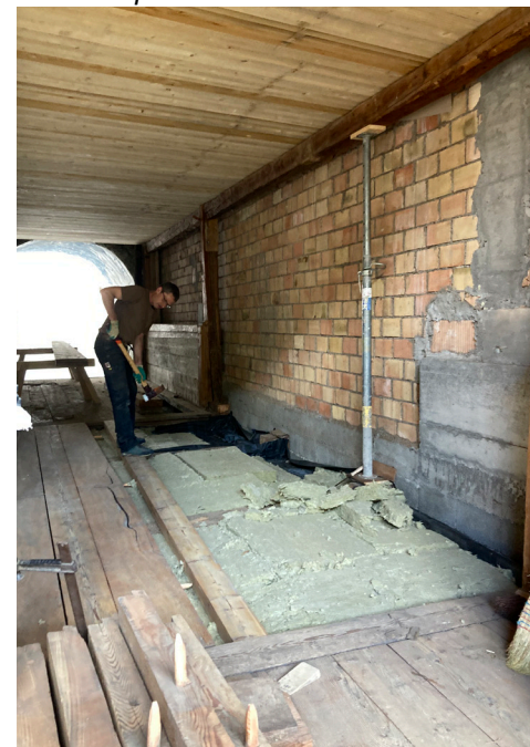
Dämmung Boden EG 28.05.2023
