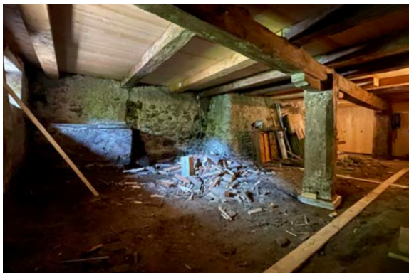
Auflager Boden, untergossener Pfosten
